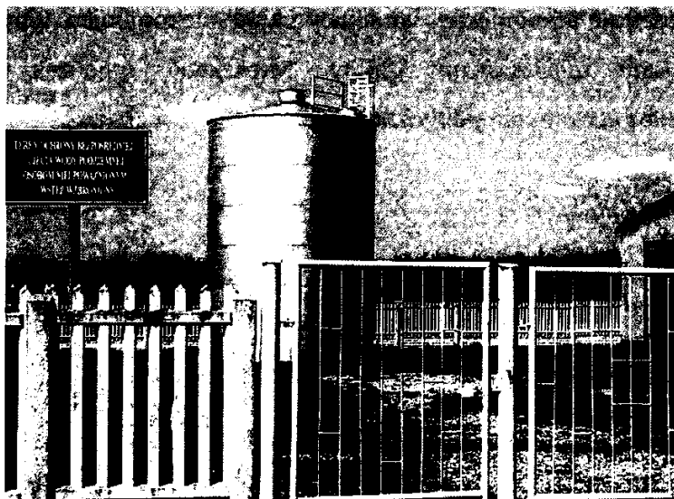
Zdjęcie 17: Ujęcie wody w Sokółowie Górnym
