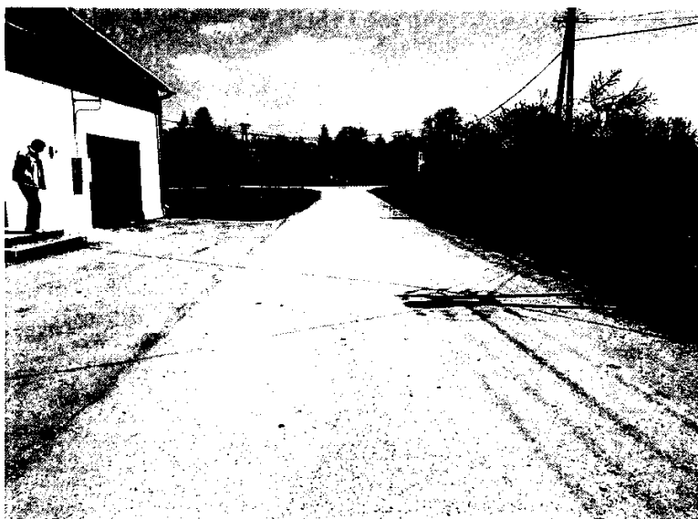
Zdjęcie nr 9 Droga gminna
